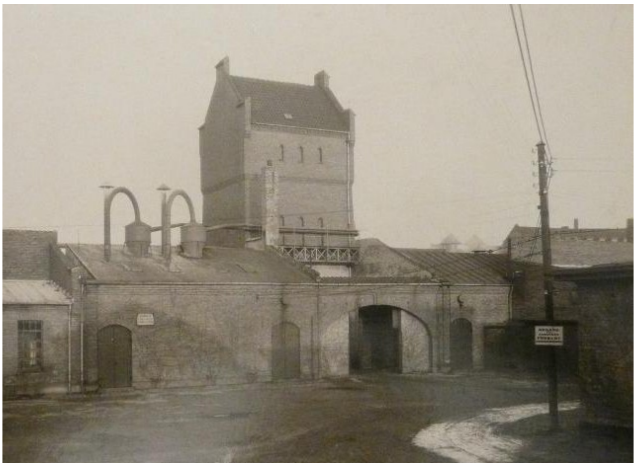
Vandtårnet og gennemkørslen mellem fabriksbygningerne - ca. 1912
