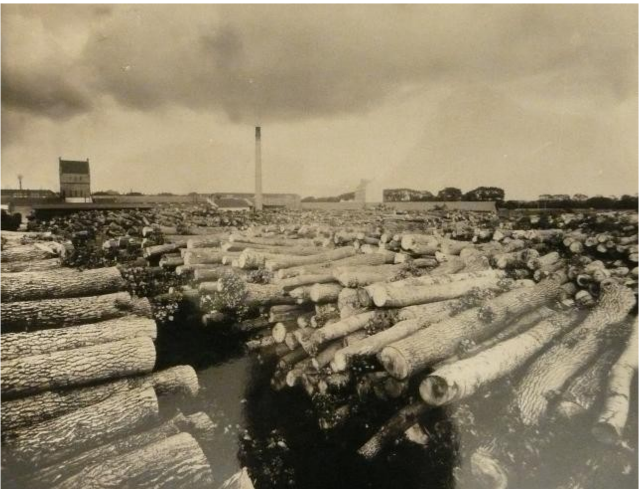
Træpladsen set mod nordøst, i baggrunden vandtårnet og kedelhusets skorsten - ca. 1925
