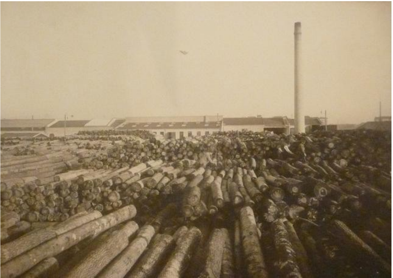
Træpladsen set mod nord , i baggrunden den østlige fabrikbygning og kedelhusets skorsten - ca. 1920
