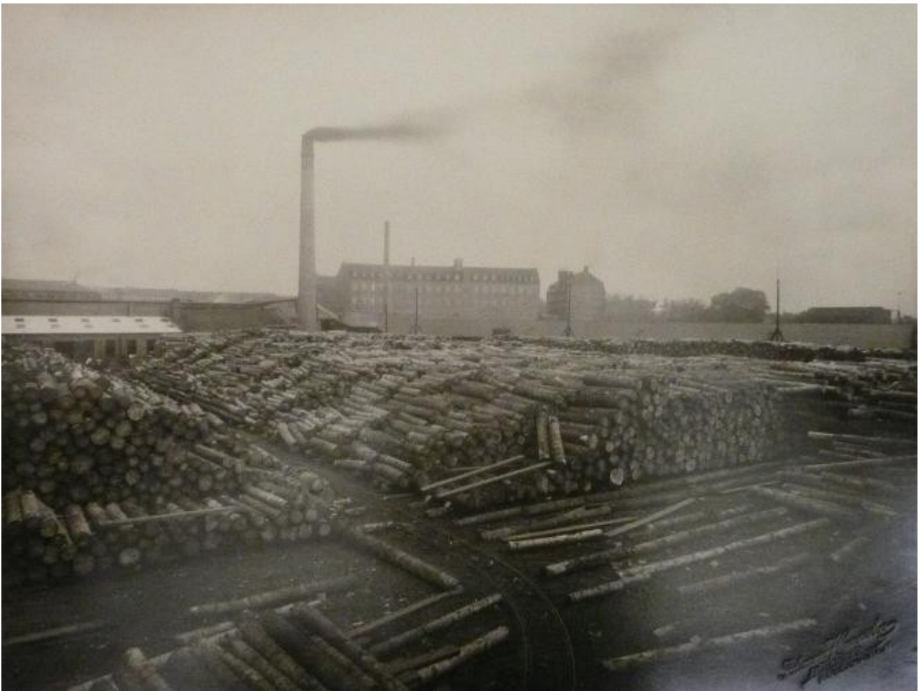
Træpladsen set mod nordøst, i baggrunden kedelhusets skorsten - ca. 1930
