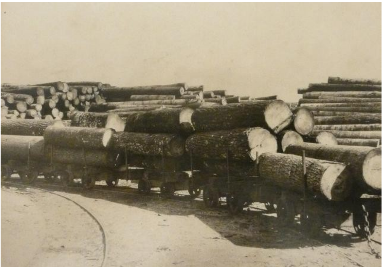
De specielle små og smalsporede tendervogne, der senere overtog hestenes arbejde med at trække vognene ind.
