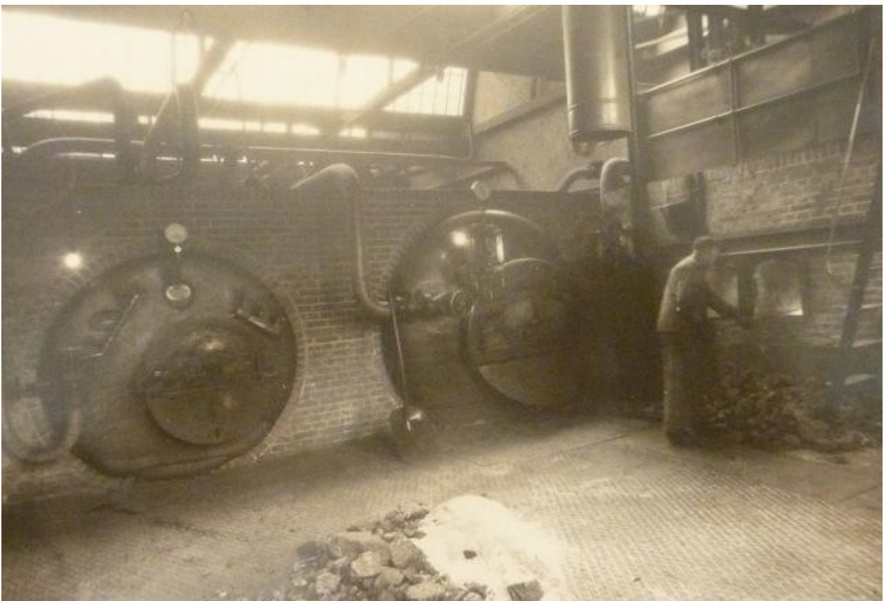
De gamle kylfyrede korniske kedler
