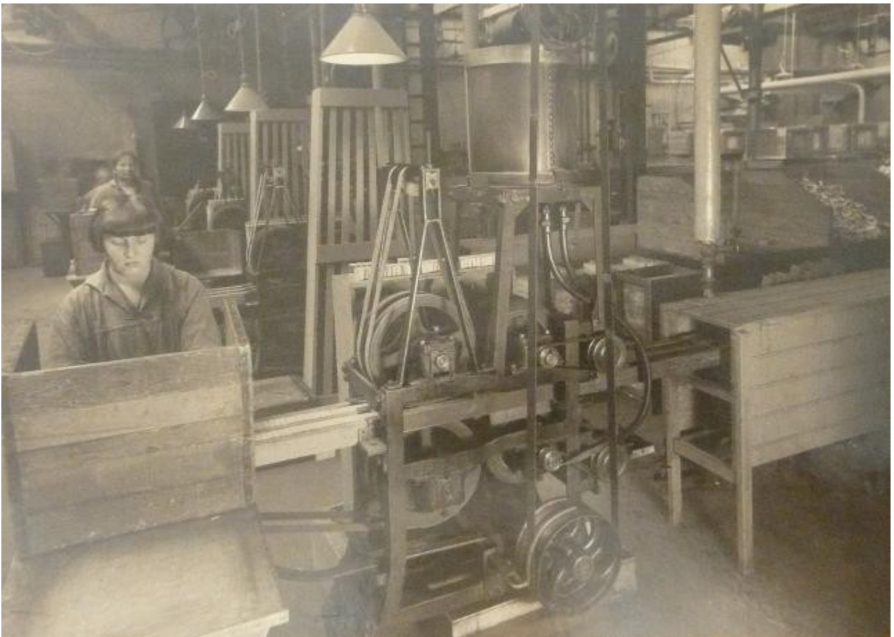
Strygemaskinerne, hvor strygemassen kommes på siden af æskerne
