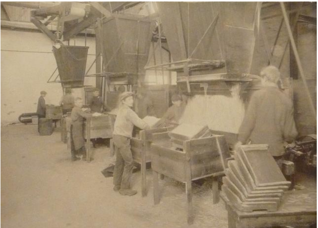
Oprettemaskinerne, hvor stikkerne manuelt rettes op og lægges parallelt
