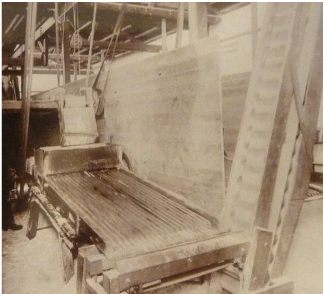
Den fortsatte transport via bånd og kopelevator
