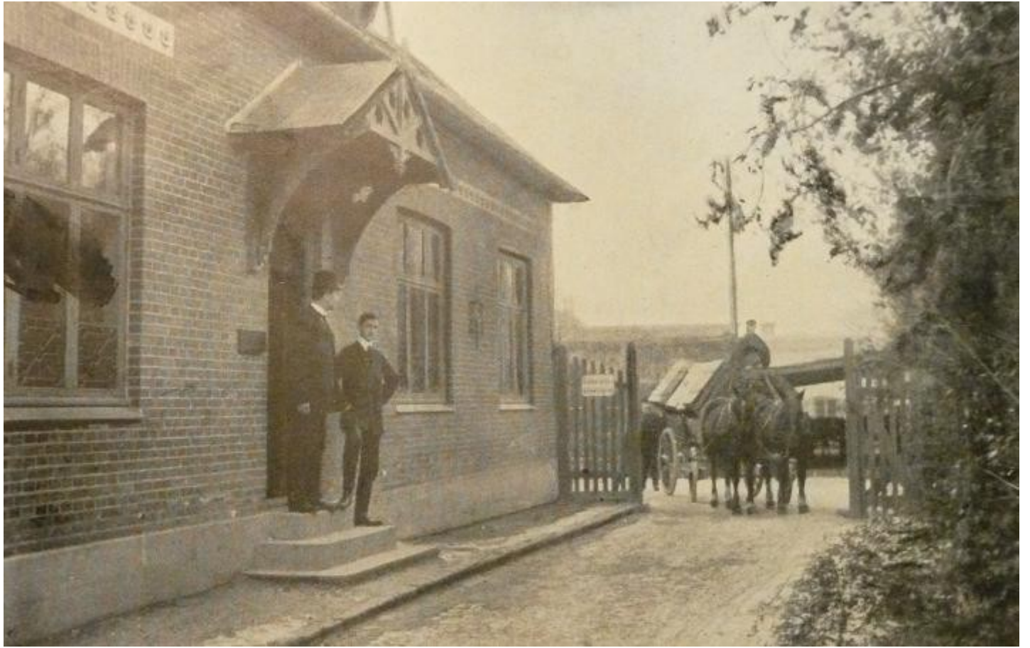
Indkørslen til fabrikken
