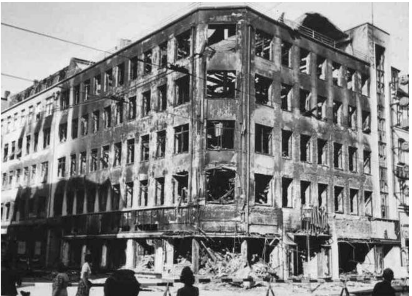
Den totalt udbændte bygning, som var opført i 1940 af Bryde Nielsen
